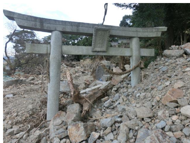
正面階段下、道路脇の鳥居は土砂に埋もれ、この横にあった石碑も流失しています。
